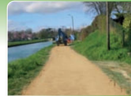
**Chemin de halage, rive droite :** un grave laitier a été étendu sur toute la longueur. Comme c'est la norme, le halage reste interdit à tout véhicule, sauf services autorisés et aux riverains. Des systèmes avec clés en interdisent l'accès.
